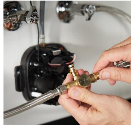
Soporte posterior a la instalación
